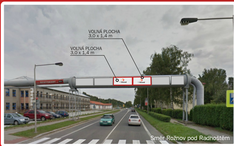
Valašské Meziříčí parovod na Rožnovské ulici
